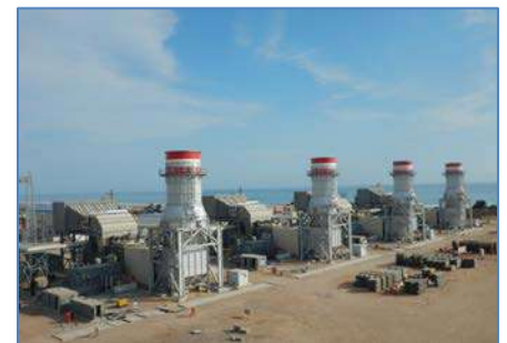
Turbinas y Generadores 1, 2, 3 y 4
