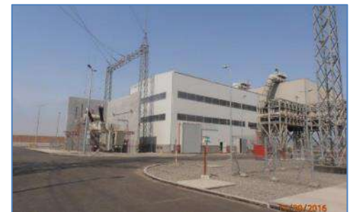
Nave de Turbina-Generador a Vapor
