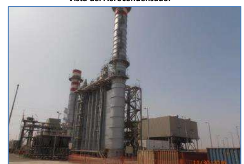
Vista de la C.T. Chilca 2
