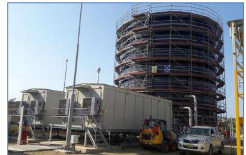
Avance de Obras
