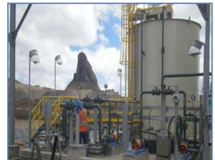
Vista general de las instalaciones
