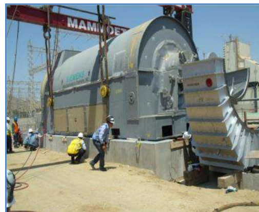
Montaje de Turbina a Gas y Generador
