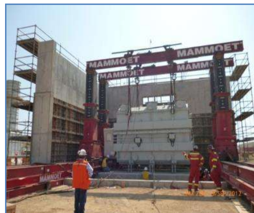
Montaje del Transformador de Potencia Concluido
