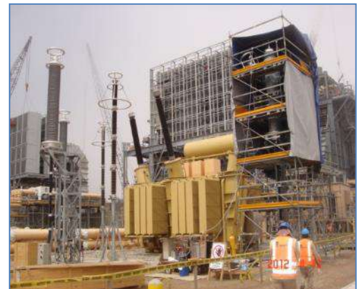
Montaje de Transformador de Potencia de T.G.
