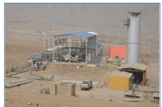
Central Termoeléctrica Huaycoloro
