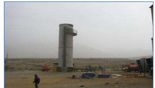
Quemador de Biogás
