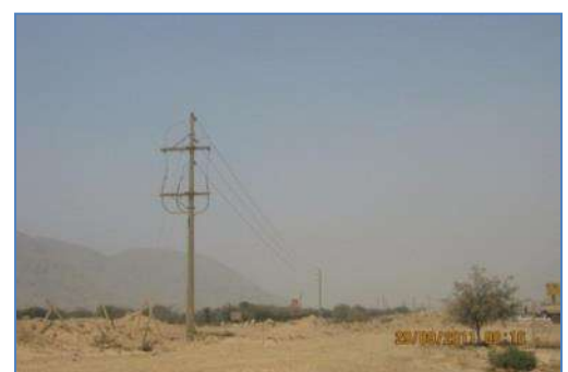
Línea de subtransmisión 22,9 kV
