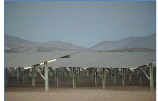
Instalación de Módulos Fotovoltaicos
