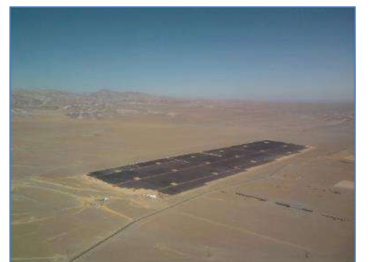
Vista panorámica de la central
