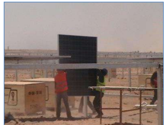
Instalación de Módulos Fotovoltaicos
