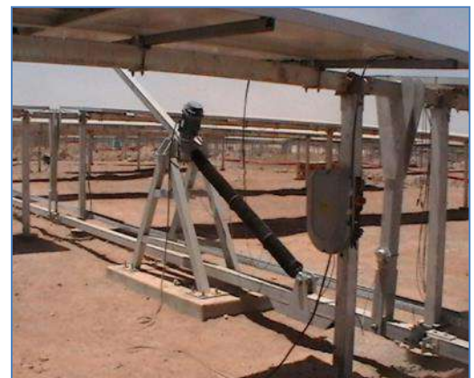
Instalación de Seguidor Solar
