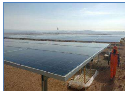
Montaje de paneles solares
