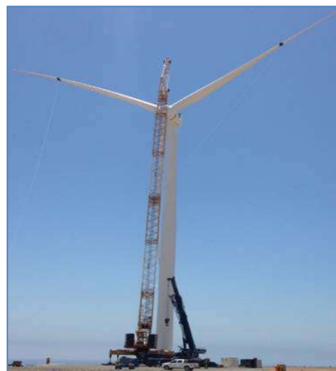
Montaje de Palas
