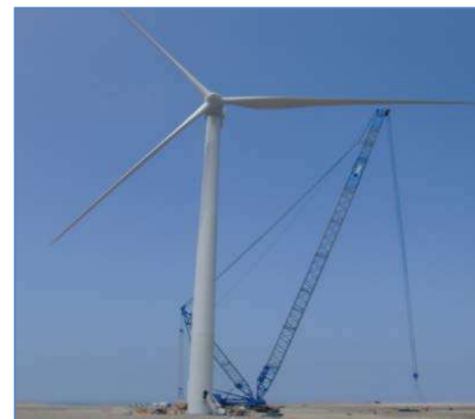
Montaje concluido del Aerogenerador
