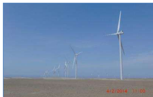
Vista de los Aerogeneradores montados
