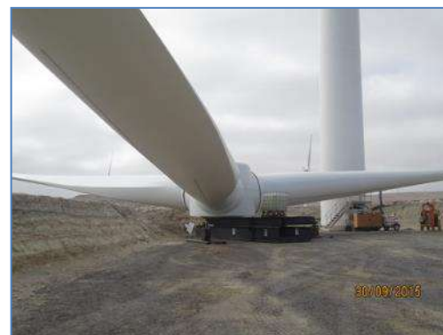
Montaje de Aspas
