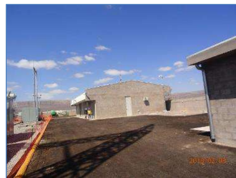
Obras civiles Subestación Flamenco
