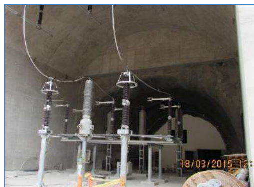
Transformador de potencia en caverna (S.E. Quitaracsa)
