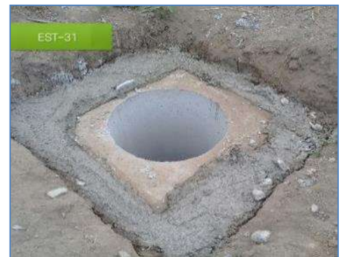
Vertido de concreto de primera fase concluido
