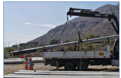
Transporte de postes para su montaje
