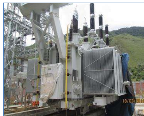
Montaje del Transformador de Potencia 55 MVA
