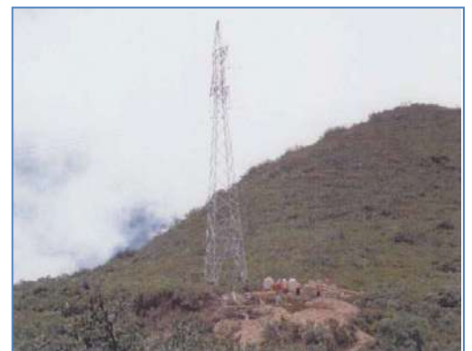
Vista de Torre TE-01
