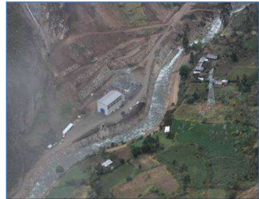
L.T. 220 kV SE Runatullo III – SE Concepción
