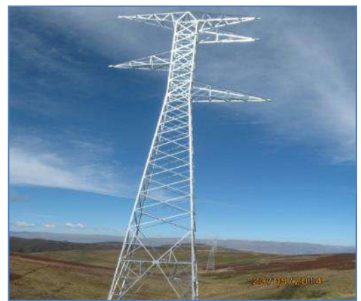
Vistas de Torres en la L.T.
