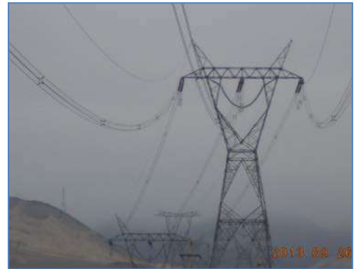
L.T. 500 kV S.E. Fénix – S.E. Chilca
