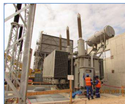
Montaje del Transformador de Potencia (S.E. Recka)
