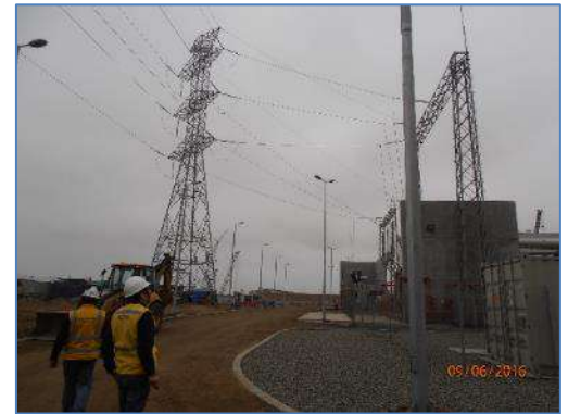
Pórtico y 1ra estructura de la L.T.
