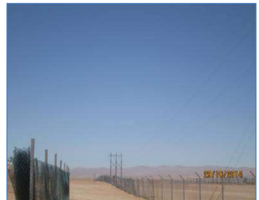
Vista de los postes de madera
