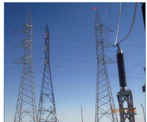
Torres de interconexión a línea existente
