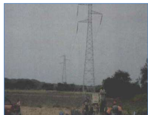
Estructura de la L.T concluida
