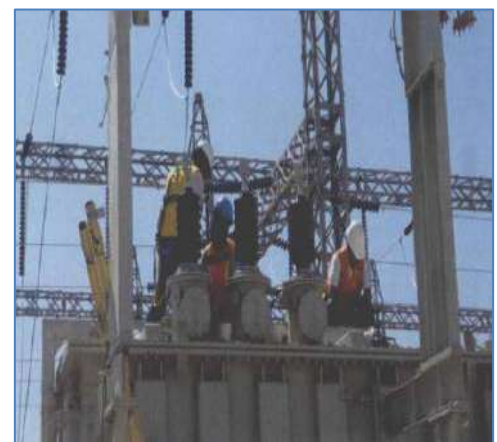
Montaje de bushing del Transformador de Potencia
