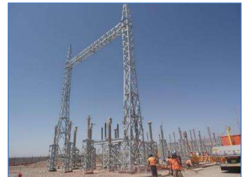
Montaje electromecánico de la S.E. Flamenco
