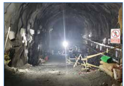
Caverna de Transformadores
