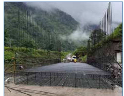
Nuevo Canal de Descarga
