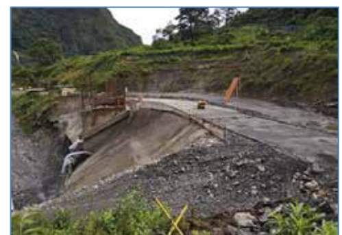
Relleno de torre de admisión
