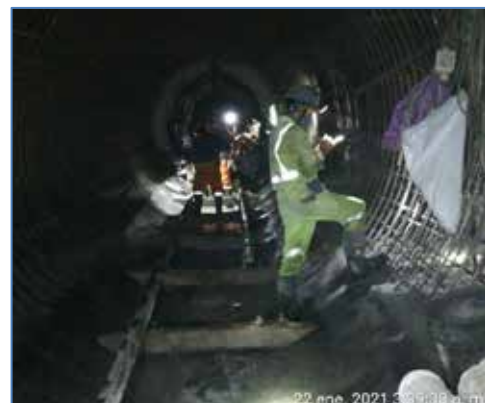
Revestimiento de concreto armado en tramo 3A
