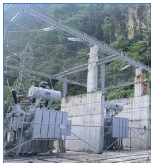
Techo rígido sobre la Subestación elevadora
