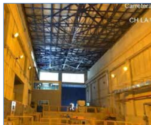
Techo rígido sobre Casa de Máquinas
