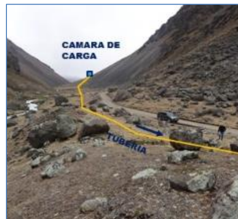
Cámara de Carga
