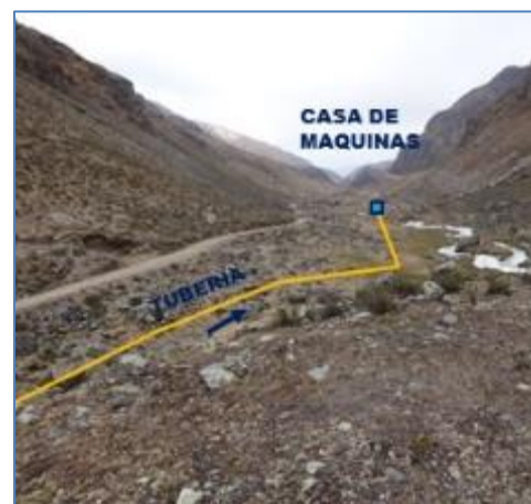
Casa de Máquinas
