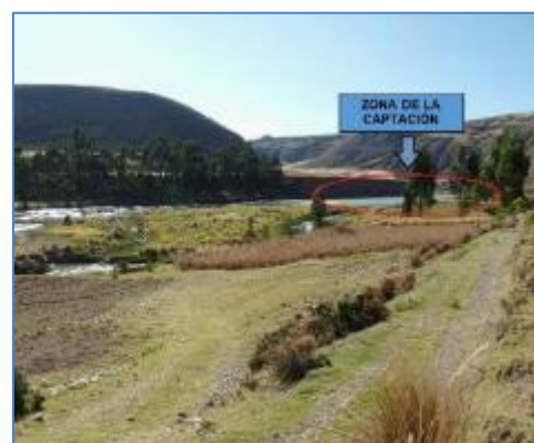
Zona de la Captación C.H. Miraflores
