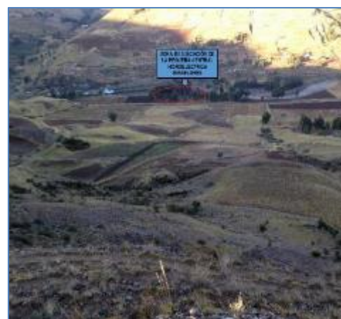
Zona de la Casa de Máquinas C.H. Miraflores
