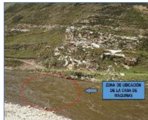
Zona de la Casa de Máquinas de la C.H. Casca
