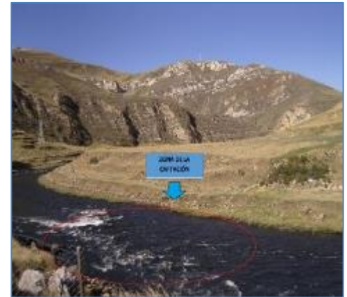
Zona de Captación
