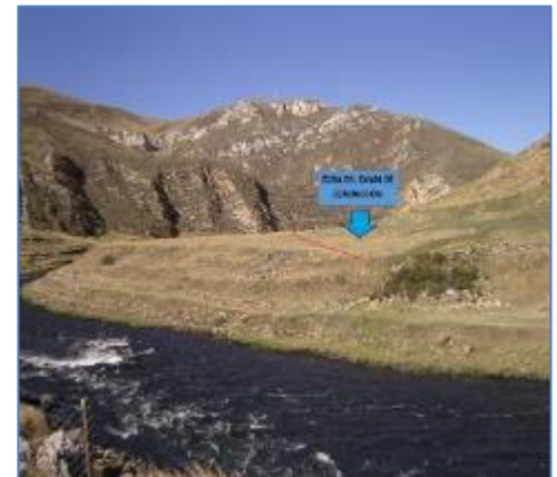
Zona del Canal de Conducción
