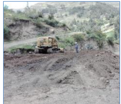
Excavación y Explanación para Canal de Conducción (segunda etapa)
