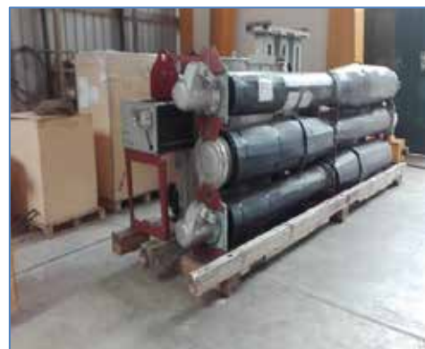
Área de ampliación (Casa de Máquinas II Etapa)
