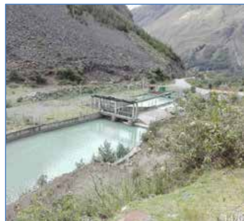
Vista panorámica de Obras de Captación – Bocatoma
