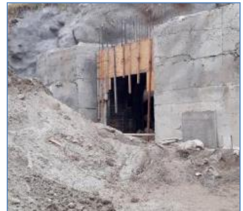
Inicio del Túnel de Aducción
