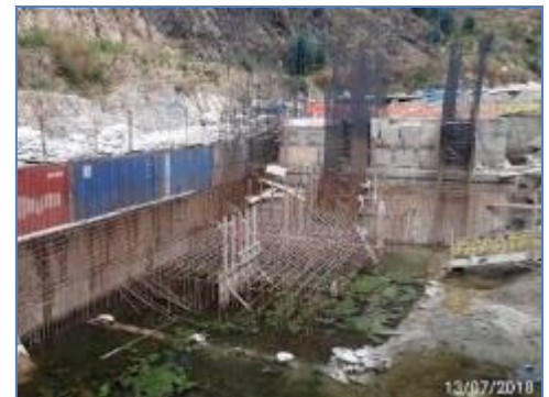
Bocatoma – Pilares de barrage móvil
