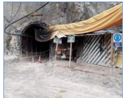
Ventana 3 – Ingreso a frentes 4 y 5 del Túnel
