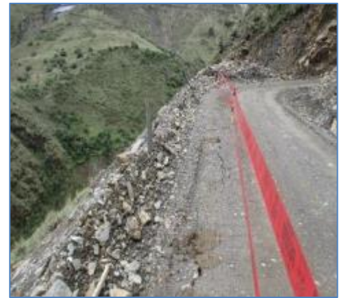
Replanteo de trazo topográfico
