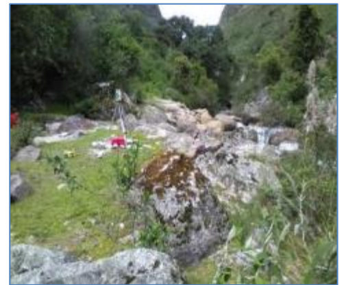
Replanteo de trazo topográfico
