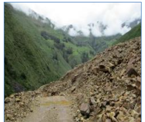
Replanteo de trazo topográfico
