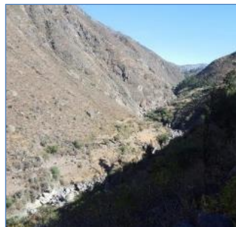
Primer tramo del Canal de Conducción
