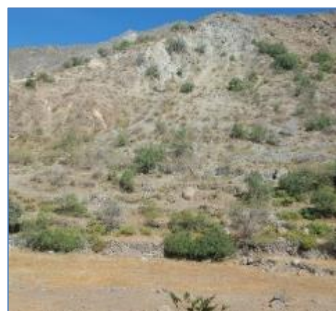
Zona de Tubería Forzada
