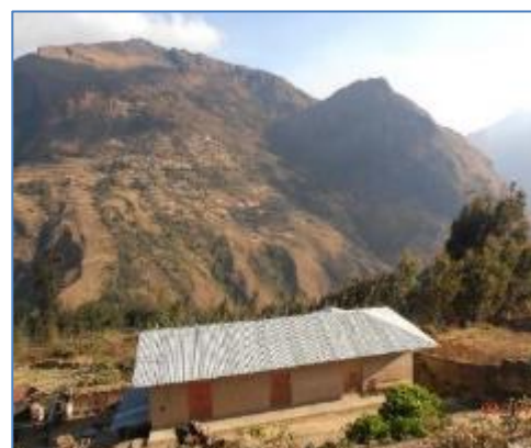
Zona de la Tubería Forzada
