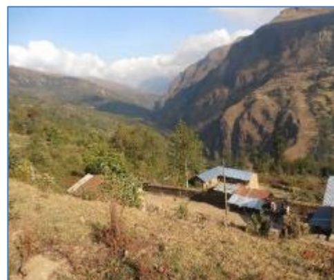
Zona del Canal de Aducción
