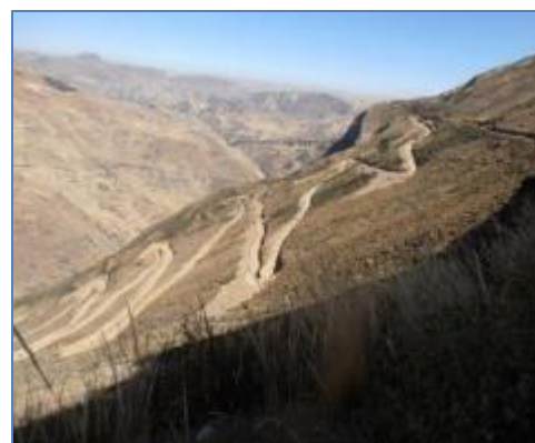
Camino de acceso a la Casa de Máquinas
