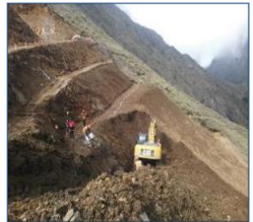
Limpieza de material suelto en talud
