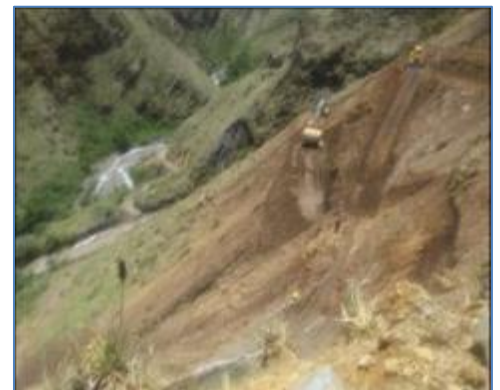
Limpieza a nivel de subrasante, perfilado de talud
