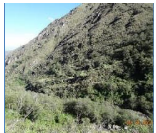
Vista panorámica de línea de conducción
