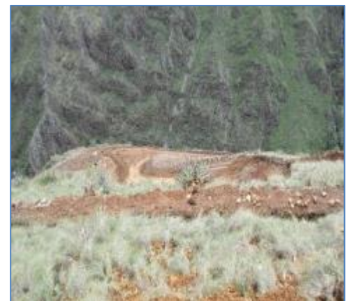
Replanteo de trazo topográfico
