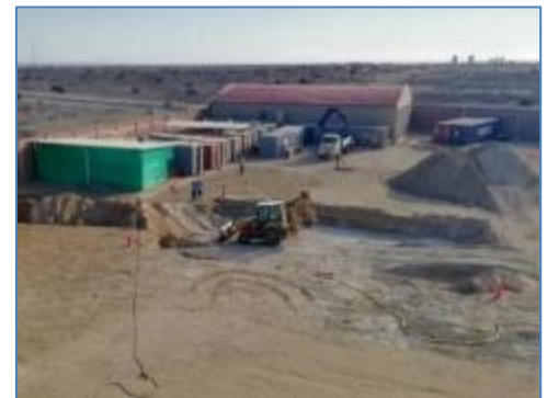
Excavación en la planta C.T. Tallanca
