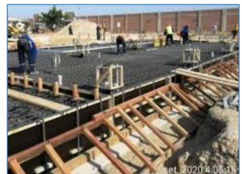
Excavación y tendido de malla a tierra
