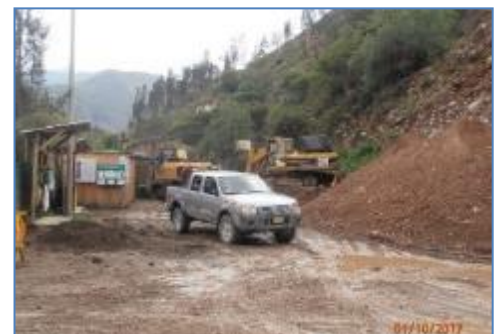
Área donde se construirá la S.E. Santa Lorenza
